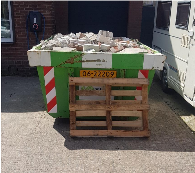
Figuur 1. Goed aangebrachte reflecterende markeringen volgens de “Richtlijn voor het markeren van onverlichte obstakels” van de CROW-publicatie 130.
